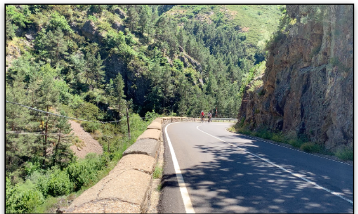
Fig. 50 Ascenso hacia Llánaves de la Reina
